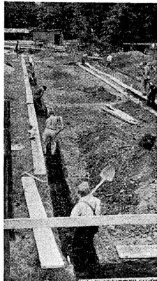
Lange Gräben werden bereits für die ersten neuen Fundamente ausgeschachtet. An anderer Stelle sind Arbeiter mit einer Mauer, die den vorderen Teil des Gebietes mit der Staatlichen Wilhelmschule und der Werkakademie abschirmen soll, beschäftigt. Das neue Kasernengelände ist für belgische Panzertruppen bestimmt und liegt so, daß die Panzer selbst ohne Behinderung stark beanspruchter Straßen zu ihrem Übungsgelände auf der Dönche rollen können. (Aufn.: HN/L)
